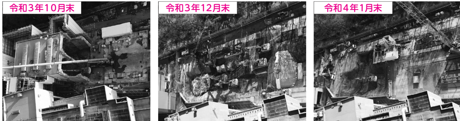
解体現場北側からの状況
