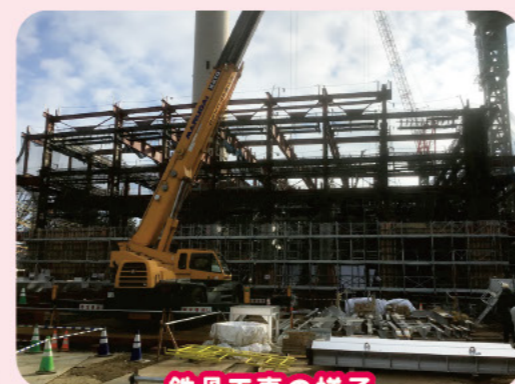
鉄骨工事の様子
