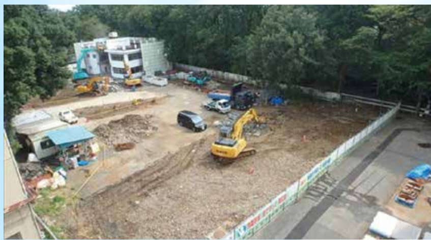
平成30年9月 旧小平市清掃事務所の解体を始めました。
