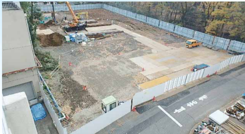
平成30年12月 山留工事：掘削予定場所の外周に崩落防止のためのH鋼を建て込んでいます。
