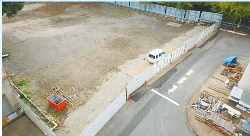
平成30年11月 解体が完了しました。
