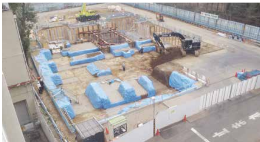
平成31年2月 基礎工事：掘削した地下部に鉄筋を組み、コンクリートで基礎を作る作業をしています。
