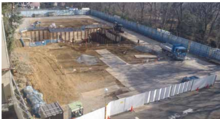
平成31年1月 土工事：地中構造物を施工するための掘削作業(ピット部は約8m、躯体全体は約2m)と、山留工事に建て込んだH鋼に木製矢板を設置しています。
