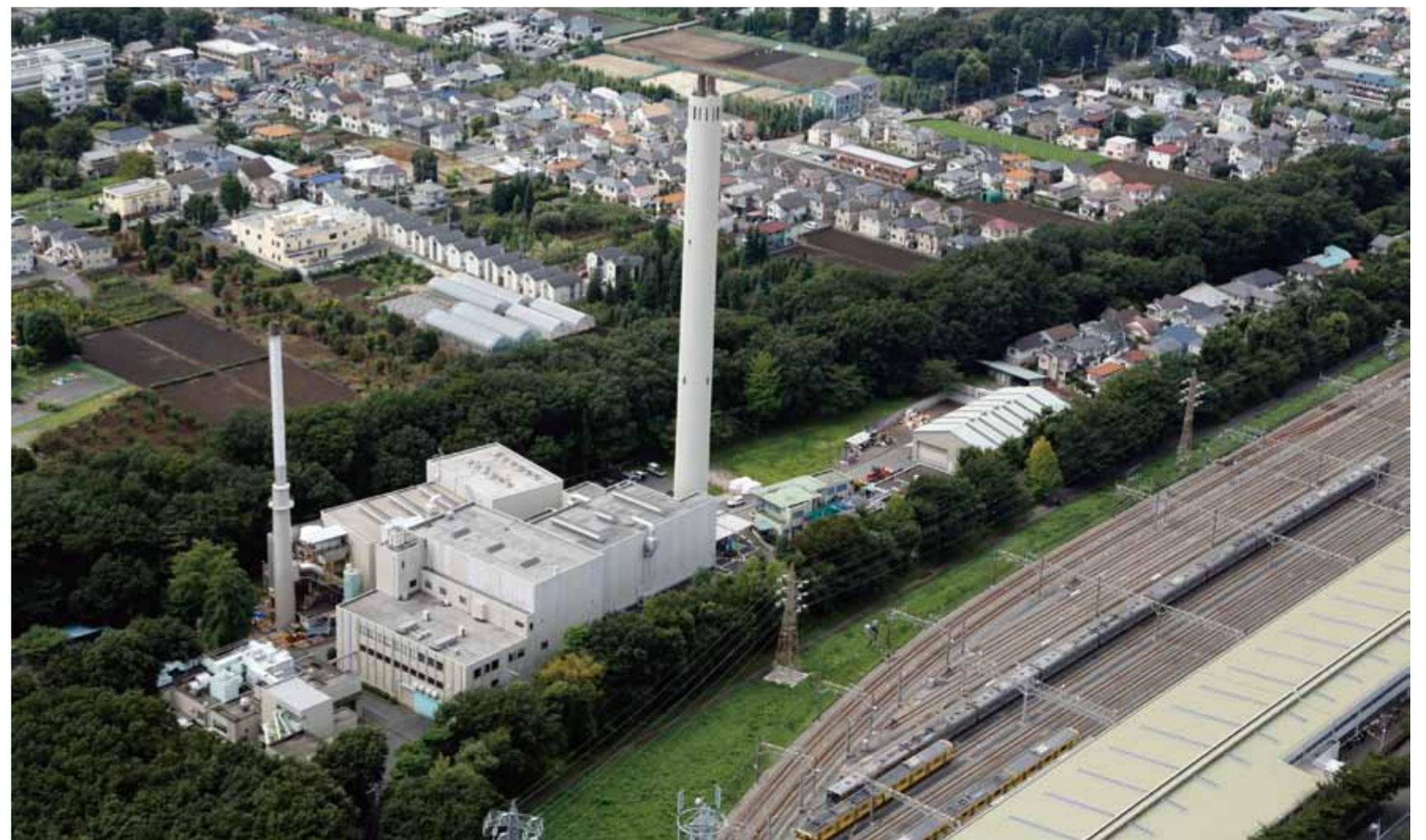
<写真：衛生組合(小平市中島町2-1)を撮影>
