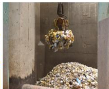
ごみピットの様子です
