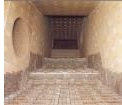
焼却炉の内部
